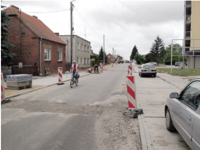
Drugi etap przebudowy ul. Wielichowskiej
