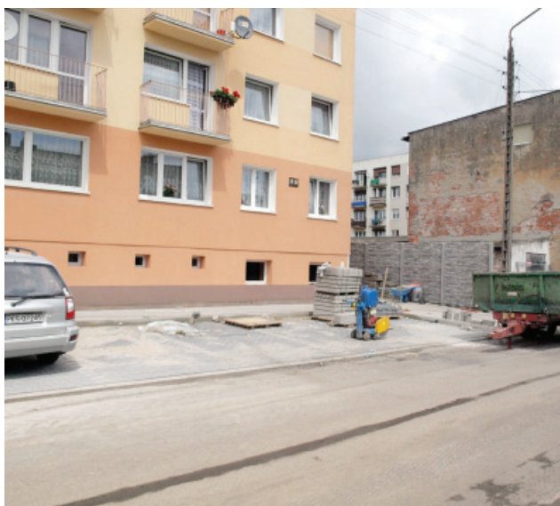
Nowe miejsca parkingowe oraz chodnik na ul. Kosynierów
