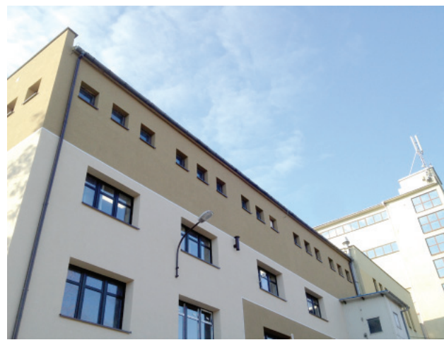
Nowa elewacja budynku na ul. Bernardyńskiej
