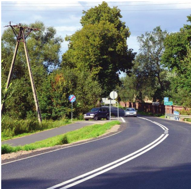
Nowa nawierzchnia została położona na odcinku 1905 metrów.
