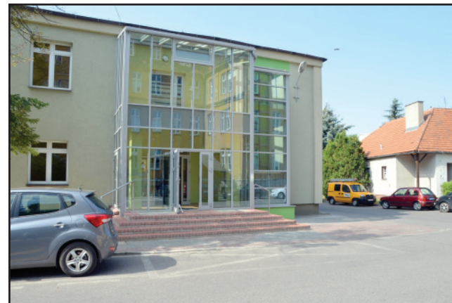
Nowa winda ułatwi transport chorych na wózkach i łóżkach. Całkowity koszt budowy windy to ponad 355 240 złotych.
