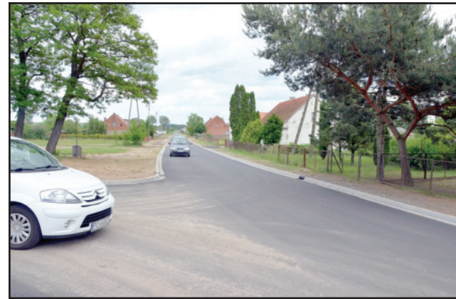
W Wieszkowie w ramach prac na prawie 500 metrach jezdni wylana została nowa nawierzchnia bitumiczna. Koszt inwestycji to blisko 413 tys. złotych.
