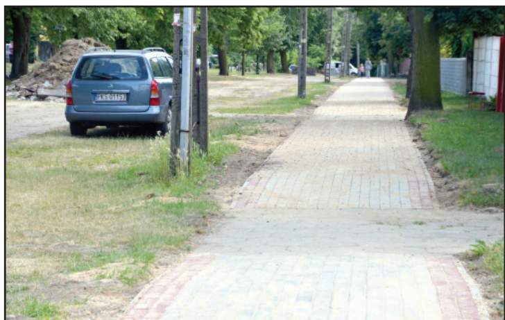
W Starym Bojanowie powstaje ciąg pieszo - rowerowy. Wyłożony został już kostką betonową, brukową, będzie miał 400 metrów długości i 2 metry szerokości. Koszt budowy wyniesie 72 tys. złotych.
