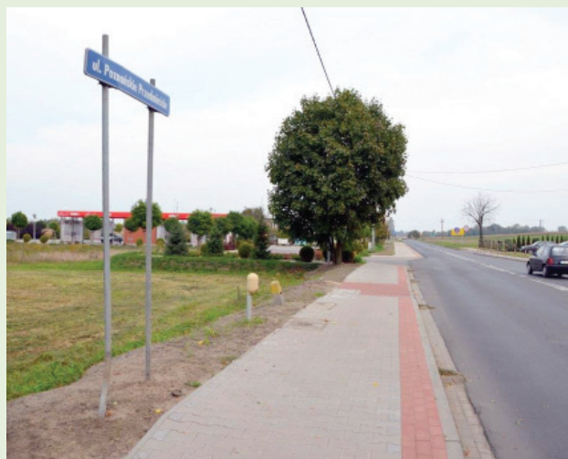
Na długości pierwszych 120 metrów ścieżka wyłożona została kostką betonową.
