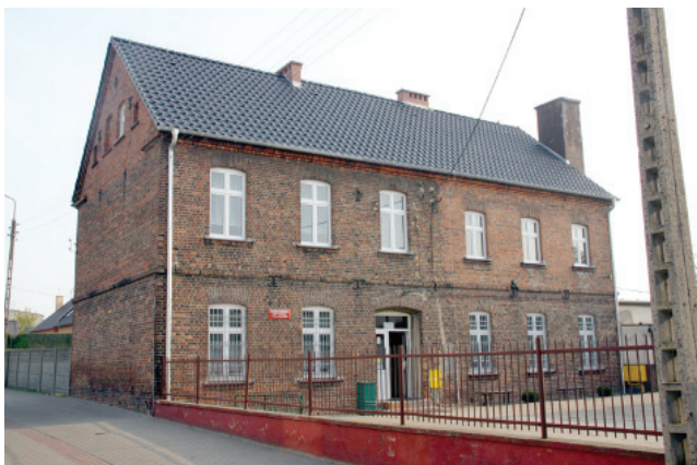
Wyremontowany dach na budynku biblioteki w Kielczie
