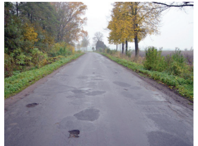
Przebudowa drogi Widziszewo-Gniewowo zakłada m.in. poszerzenie drogi i ułożenie nowej nawierzchni bitumicznej.
