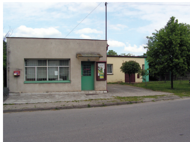
Adaptowany budynek sklepu na mieszkanie socjalne
