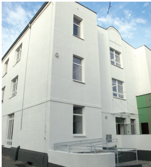
Biblioteka jest gruntownie przebudowywana i doposażana
