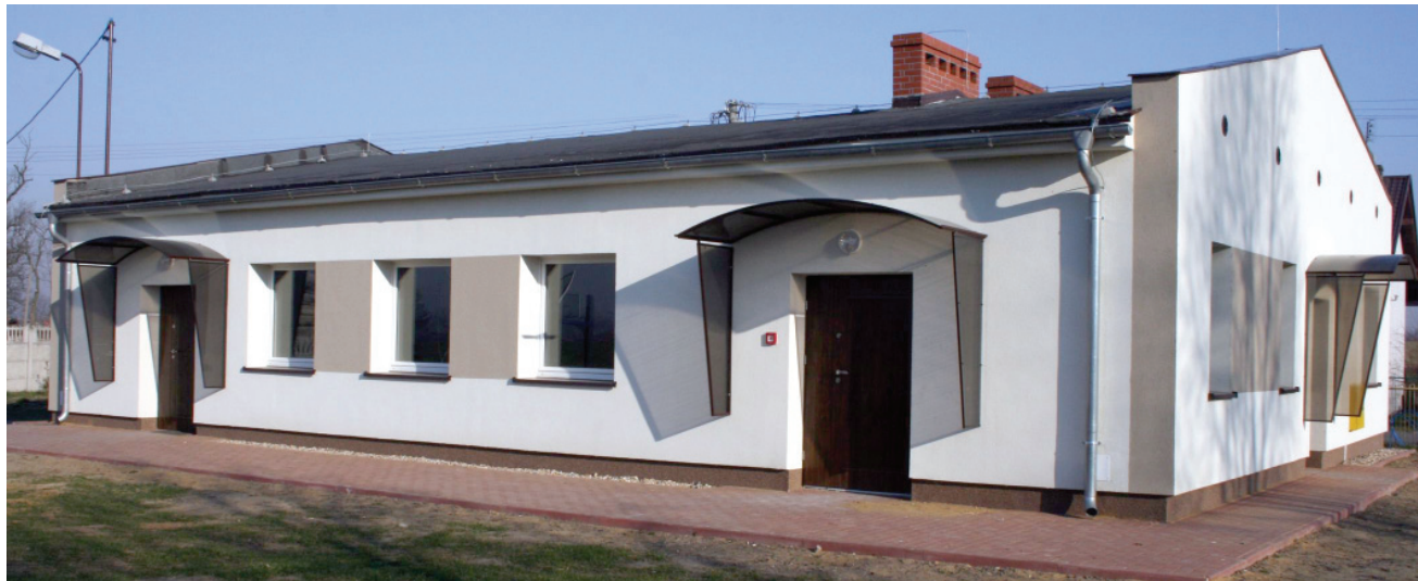
Wyremontowana świetlica w Darnowie
